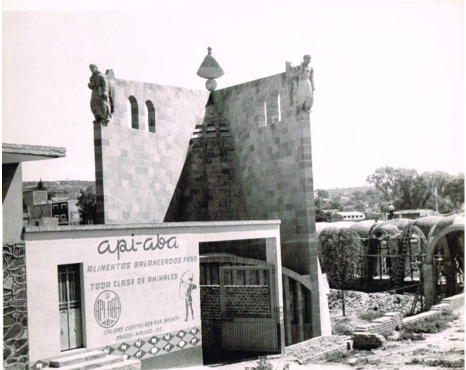
IMAGEN 11. DETALLE DE LOS ARCOS BOTARELES Y ESTATUAS, DESDE LA CALLE, DEL REFUGIO PARA PEREGRINOS
