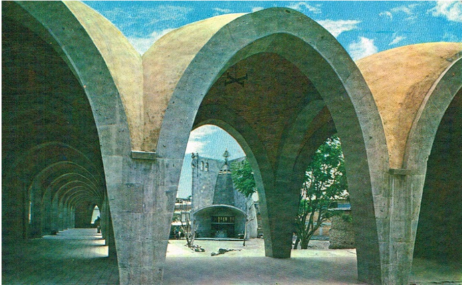
IMAGEN 8. DETALLE DE LOS ARCOS DEL PORTAL DEL REFUGIO PARA PEREGRINOS
